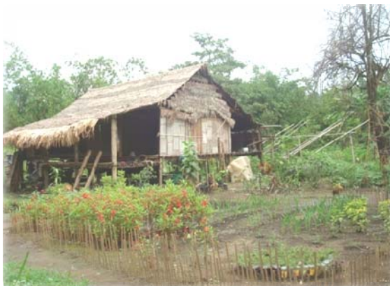
รูปที่ 39 บ้านที่สร้างด้วยไม้ไผ่ทั้งหลัง
